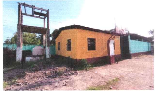
Foto 2: Vista exterior de módulo 3 de aulas, con intervención de remozamiento con mantenimiento a estructura y cambio de lámina.
