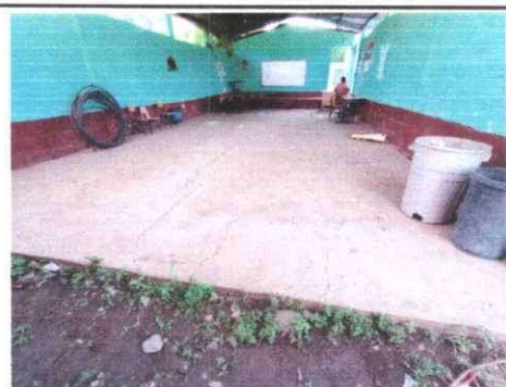
Foto 6: Vista exterior de módulo 4 de aulas, con intervención de remozamiento con suministro e instalación piso cerámico antideslizante, y muro de block (Cerramiento)
