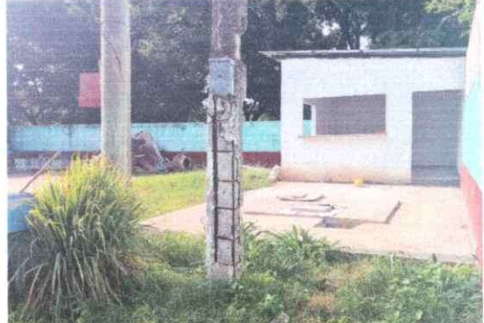
Foto 8: Vista exterior de cocina, con intervención de remozamiento con muro de block, techo, puerta y balcon
