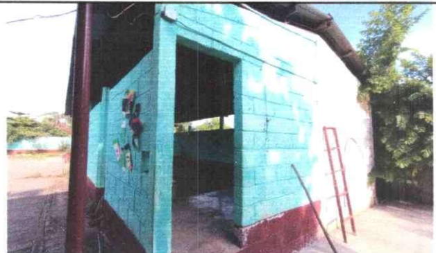
Foto 4: Vista exterior de módulo 4 de aulas, con intervención de remozamiento con instalación de estructura de techo y lámina.
