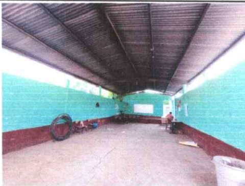
Foto 5: Vista exterior de módulo 4 de aulas, con intervención de remozamiento con instalación de estructura de techo y lámina.
